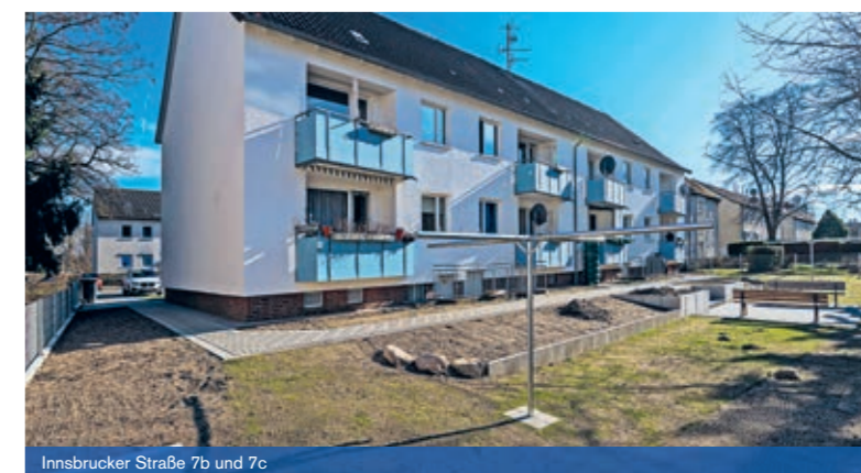
Innsbrucker Straße 7b und 7c
