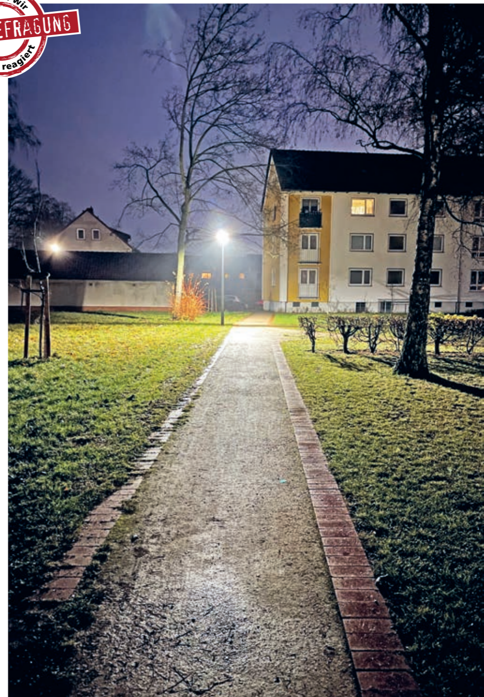
Gehwegbeleuchtung Bottroper Straße
