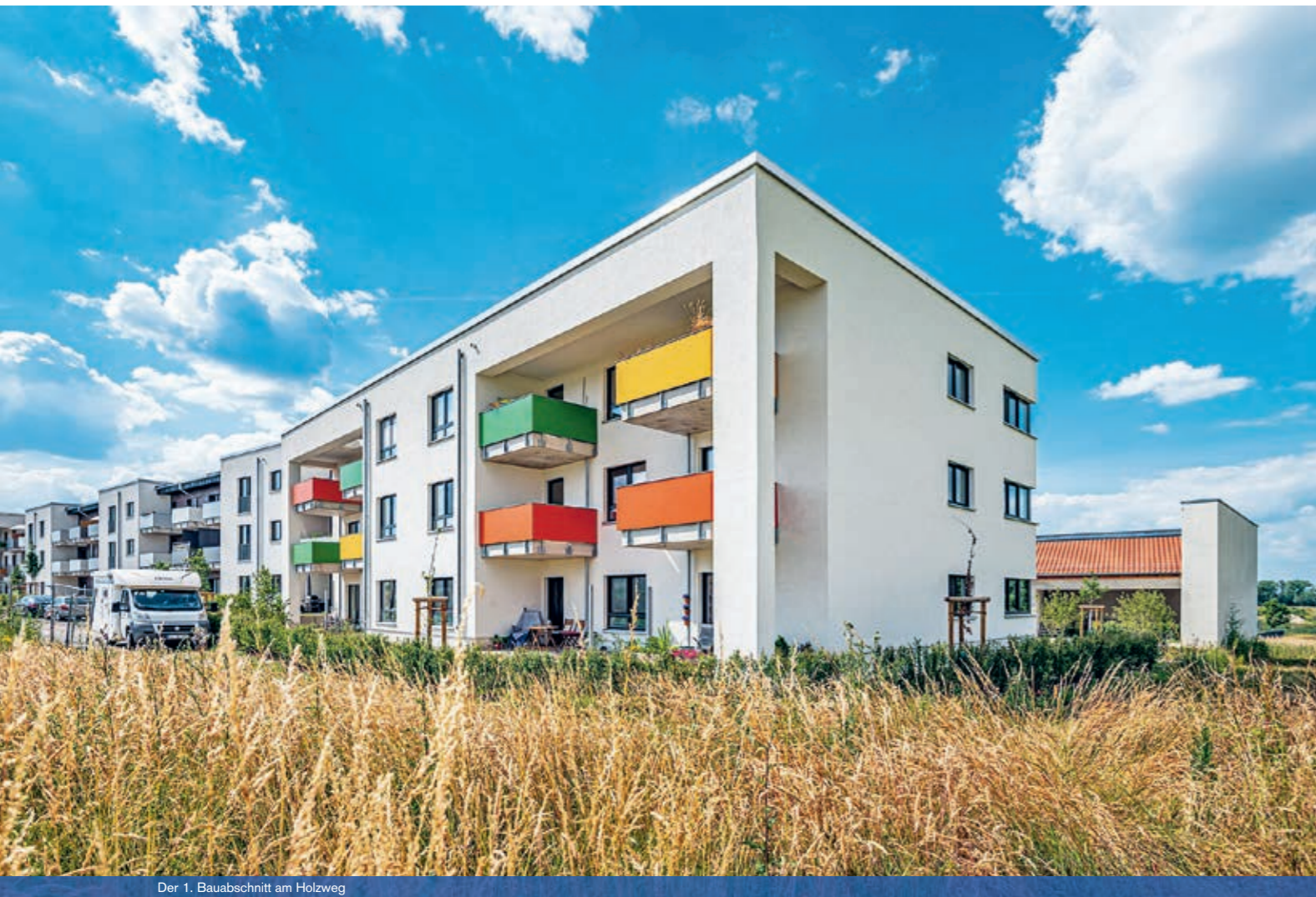
Der 1. Bauabschnitt am Holzweg
