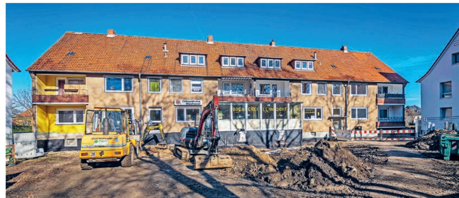
Noch eine Baustelle: Der Quartiersplatz in Lehndorf
