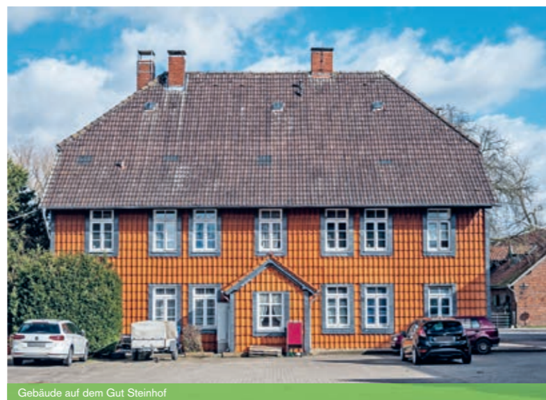
Gebäude auf dem Gut Steinhof
