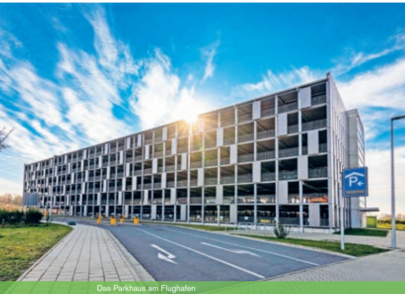
Das Parkhaus am Flughafen
