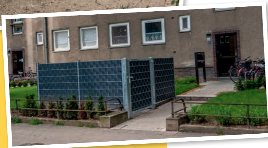
Bereits fertiggestellter Müllstandplatz im Bebelhof >
