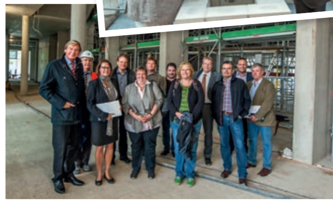
Die Nibelungen -Geschäftsführung informierte den Aufsichtsrat auf der Großbaustelle über den Neubau der IGS
